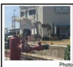
شکل ۳-۳- پخش کننده ۳۵ با ثابت فشار
